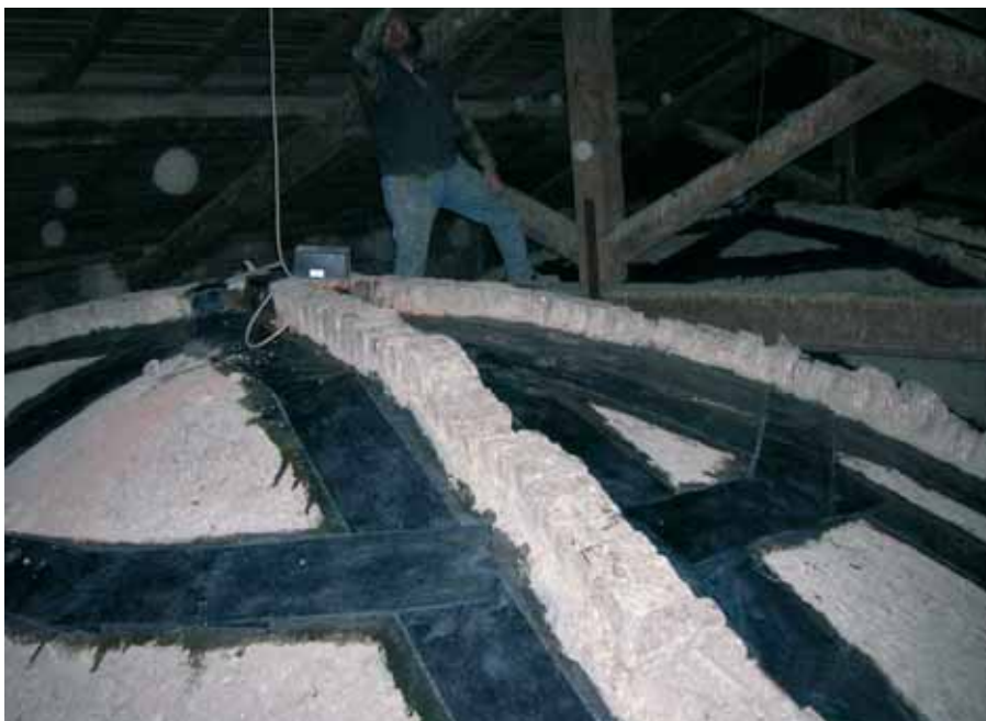
Chiesa di San Giorgio di Varignana (Bologna): rinforzo estradossale delle volte e della navata centrale danneggiate dal sisma del 2003.
