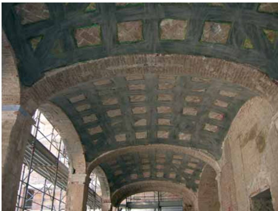
Palazzo San Geminiano, Facoltà di Giurisprudenza dell'Università di Modena: intervento di rinforzo intradossale delle volte del chiostro.
