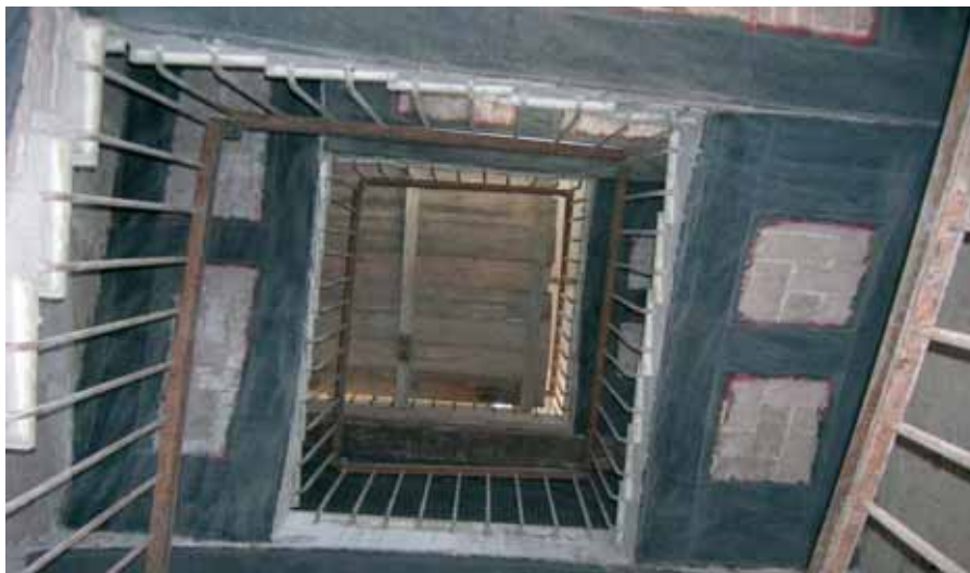
Palazzo San Geminiano, Facoltà di Giurisprudenza dell'Università di Modena: intervento di rinforzo scale.
