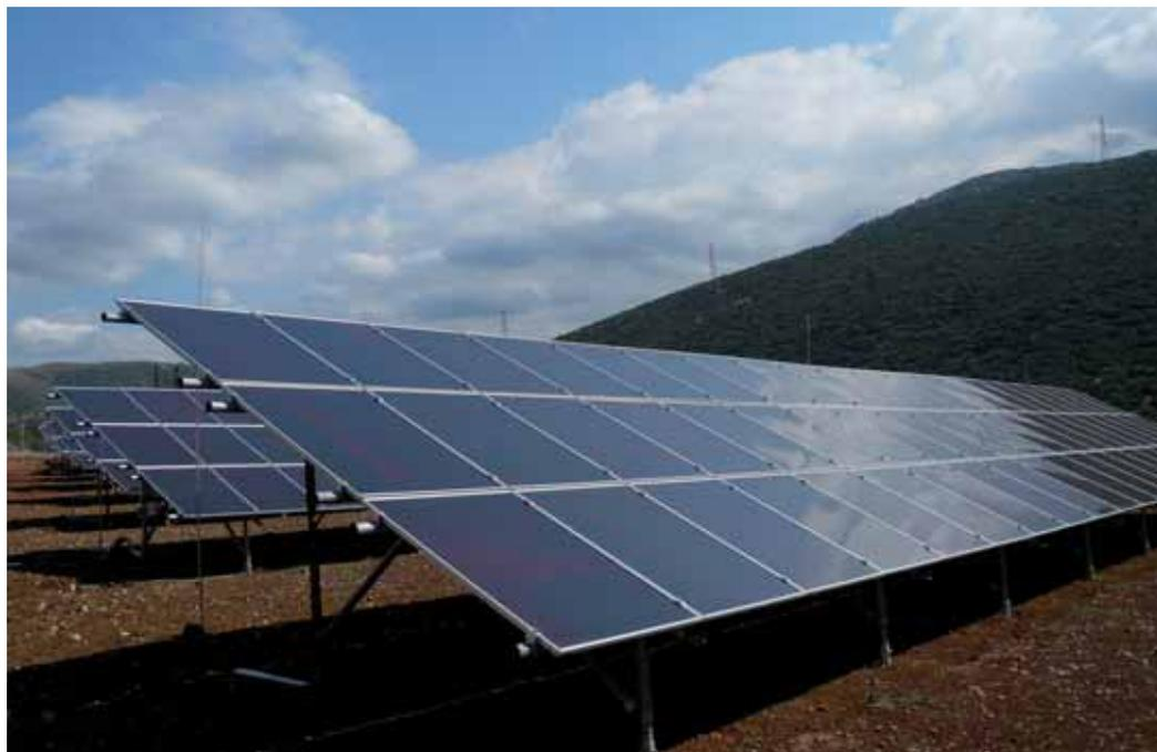
Impianto fotovoltaico a film sottile a terra
