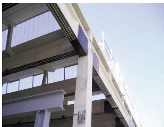
Rinforzo con il sistema Betontex® dello stabilimento Ferrari di Maranello
