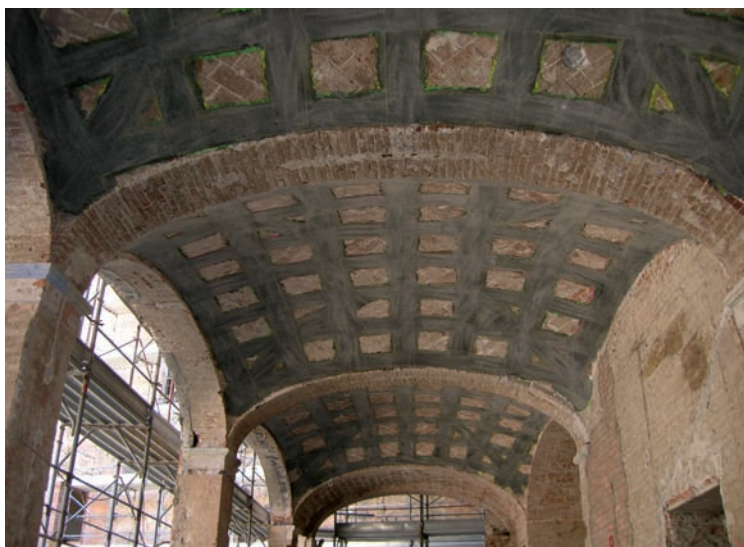
Rinforzo con Betontex® dell'ex monastero di San Geminiano, Modena
