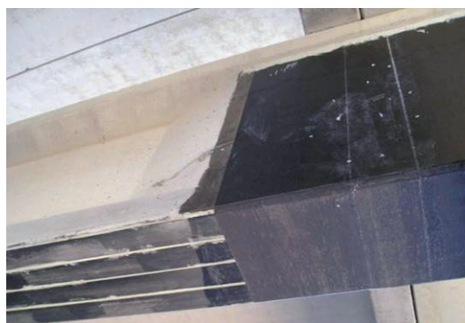
Rinforzo con il sistema Betontex® dello stabilimento Ferrari di Maranello
